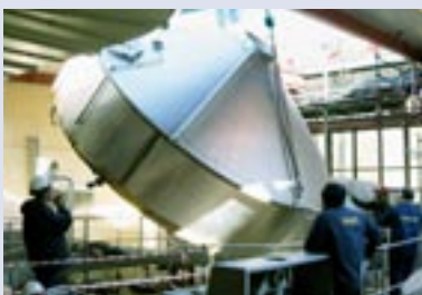
Montage von Sudhauskomponenten in Kapstadt, wenige Kilometer südlich des WM-Stadions
